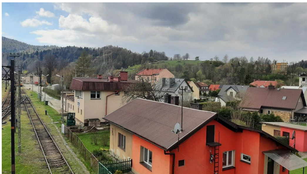
Fot. 4 Miejsce przelotu kolejki – część aglomeracyjna miasta wraz z terenem kolejowym
