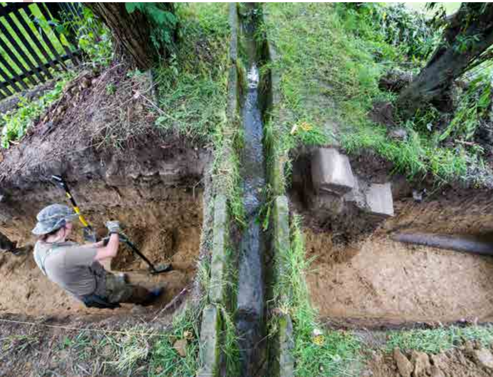
► Betónový žľab odvádzajúci zrážkovú vodu na vrchole násypu. Fot. A. Ginter
