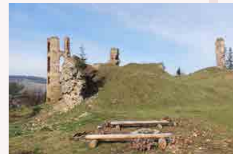
► Hrad Plaveč pred začiatkom obnovy v roku 2014
