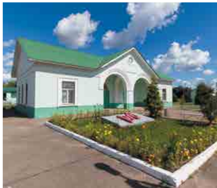
► Železničná stanica v Gniezdowe. Fot. A. Ginter
