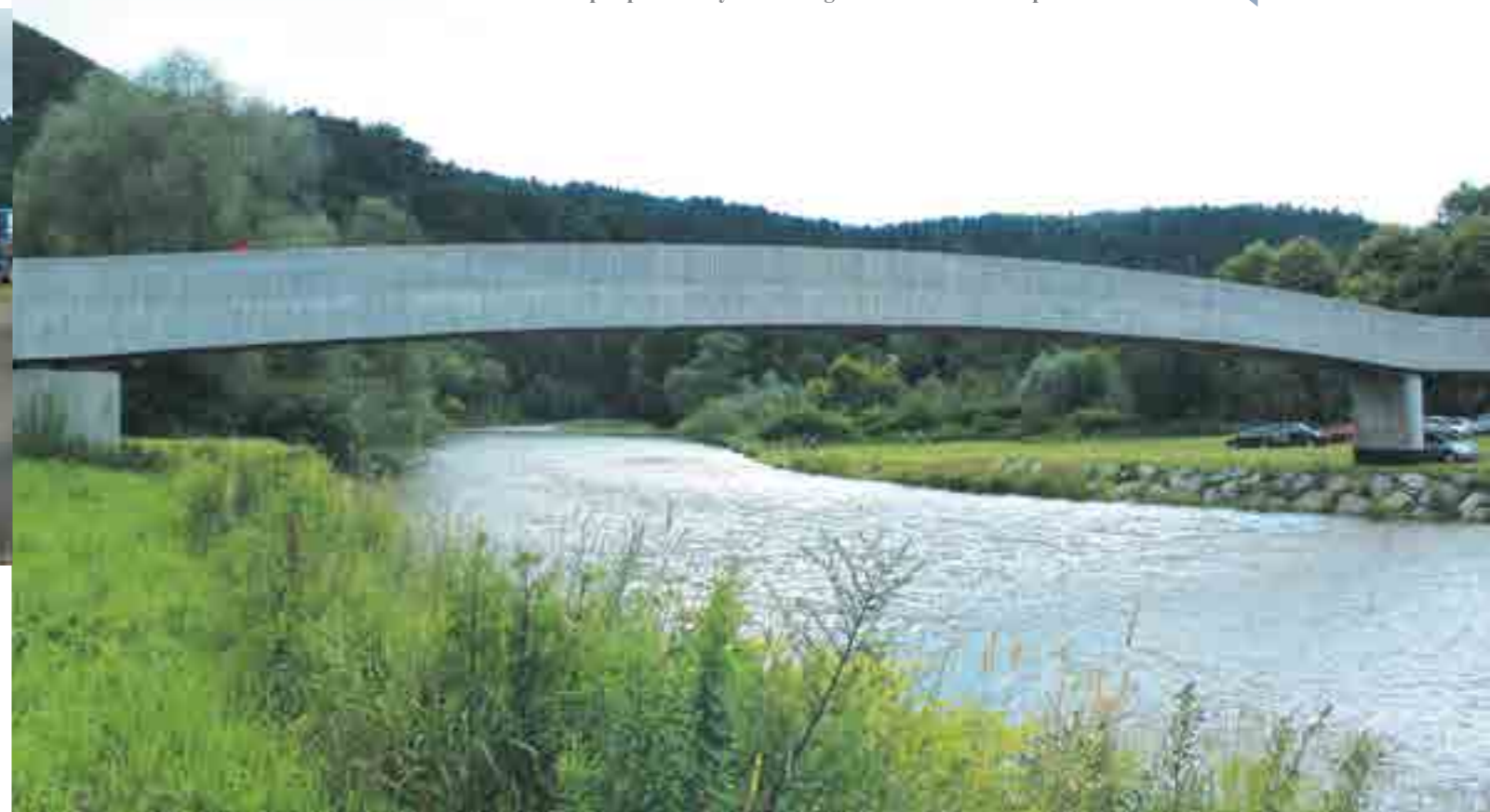
Lávka pre peších a cyklistov Žegiestow – Sulín cez Poprad. Fot. S. Latocha
