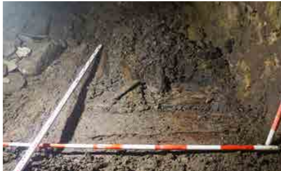
▶ Bastcja południowo-wschodnia, pierwsze piętro – drewniana podłoga z lat 1612–1613
