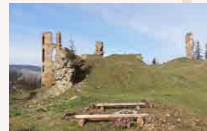
► Zamek Pławiec przed rozpoczęciem prac renowacyjnych w 2014 r.
