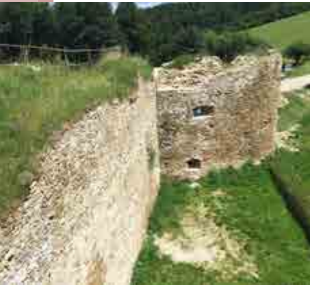
◀ Południowy mur obwodowy z bastcją południowo-wschodnią po renowacji
