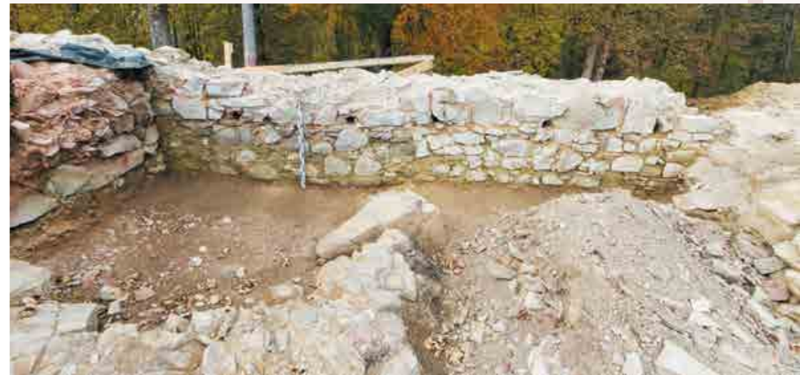
► Północna ściana murowanego budynku o charakterze gospodarczym, dostawionego do północnej ściany kurtynowej zamku, bezpośrednio przy bramie wjazdowej. Fot. A. Ginter
