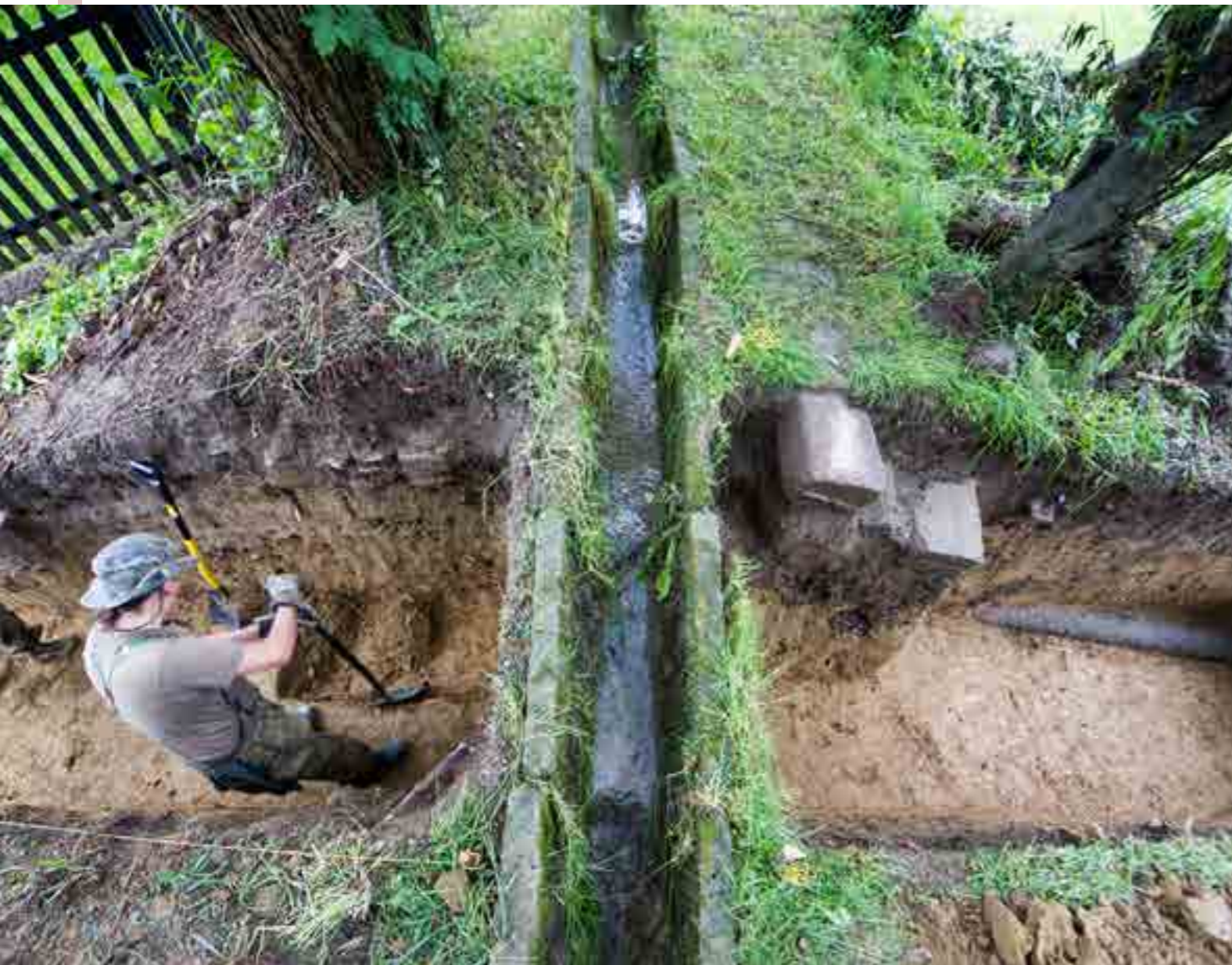
► Rynna cementowa odprowadzająca wody opadowe po szczycie wału. Fot. A. Ginter
