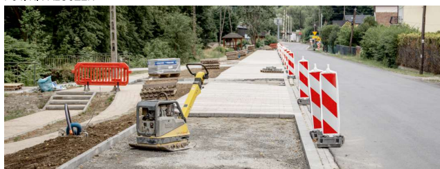
Promenada w Żegiestowie - w trakcie budowy FOT. K. PALUSZEK
