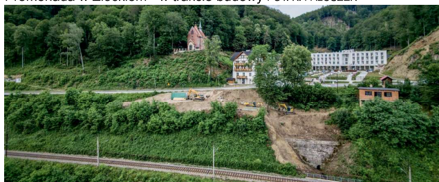
Kamienna plaża w Żegiestowie - w trakcie budowy FOT. K. PALUSZEK
