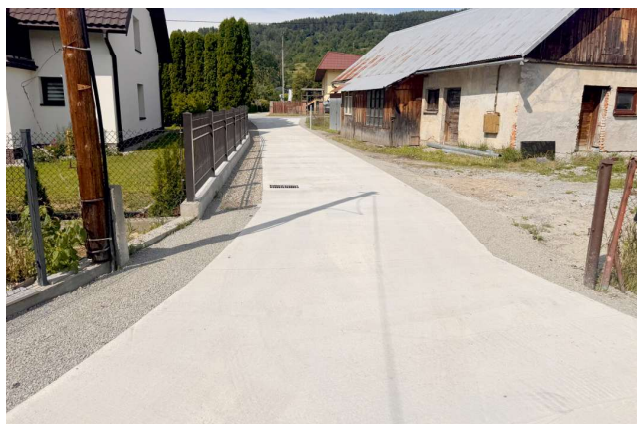
ul. Uroczą w Powroźniku po remoncie FOT. ARCH. UMIGU MUSZYNA
