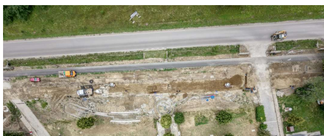
Promenada w Złockiem - w trakcie budowy FOT. K. PALUSZEK
