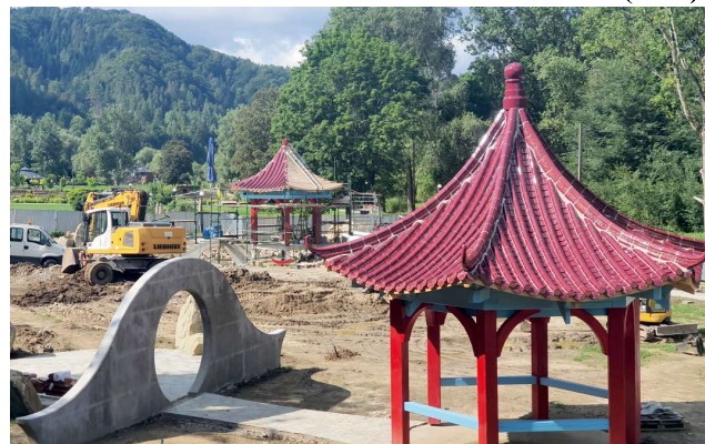
Ogród Chiński w trakcie budowy FOT. A. CYCÓN
