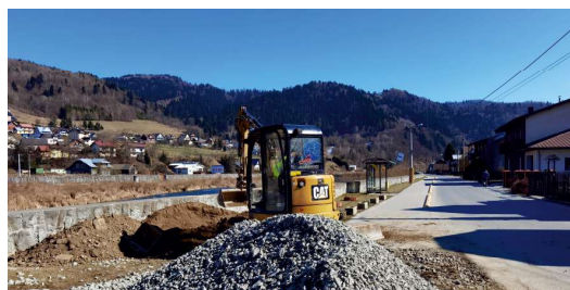
ul. Kościuszki w trakcie prac FOT. ARCH. UMIGU MUSZYNA
