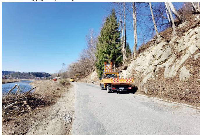
Rozpoczynające się prace przy ul. Leśnej FOT. ARCH. UMIGU MUSZYNA
