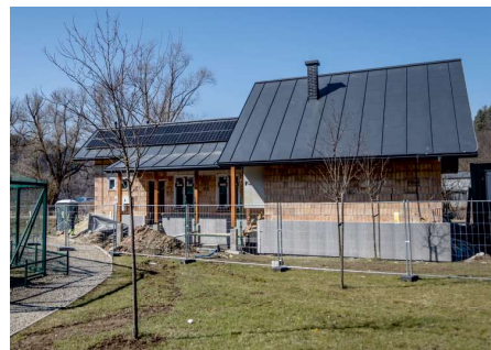
Budowa nowego budynku gospodarczego FOT. K. PALUSZEK
