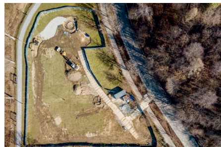
Plac budowy Ogródów Chińskich FOT. K. PALUSZEK
