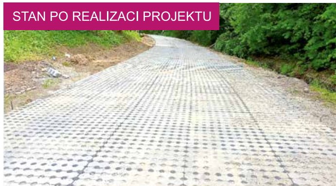
Muszyna ul. Ogrodowa - wykonano nawierzchnię betonową oraz z płyt ażurowych wartość zadania: 366 tys. zł.
