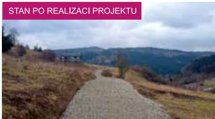
Remont drogi ul. Polna (boczna) wartość zadania: 37 tys. zł.
