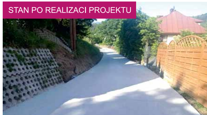
Muszyna ul. Ogrodowa - wykonano nawierzchnię betonową oraz z płyt ażurowych wartość zadania: 366 tys. zł.
