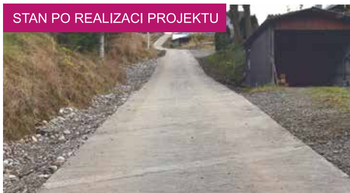
Remont drogi w Miliku wartość zadania: 98 tys. zł.
