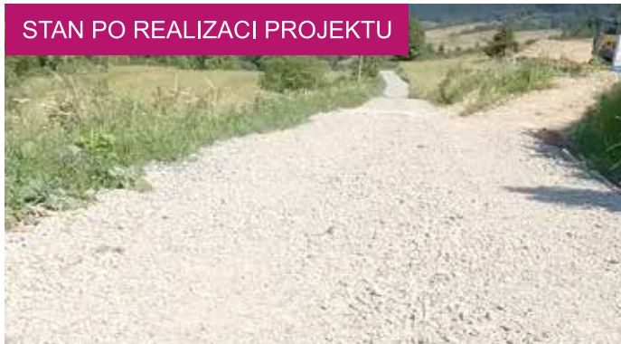
Remont drogi w Muszynie wartość zadania: 36 tys. zł.
