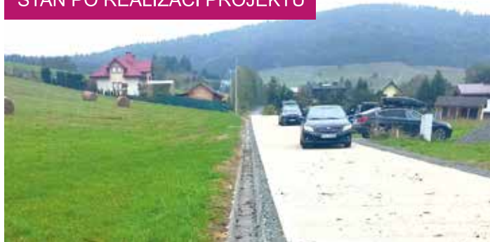
Remont drogi dojazdowej do gruntów rolnych w Jastrzębiku wartość zadania: 120 tys. zł.
