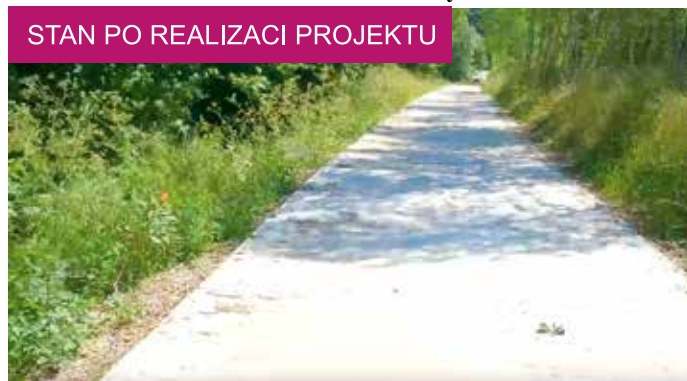
Remont drogi w Miliku wartość zadania: 70 tys. zł.
