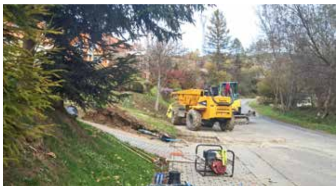
Budowa sieci wodociągowej w Złockiem FOT. ARCH. UMIGU MUSZYŃA
