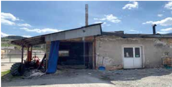
PSZOK w Powroźniku przed remontem FOT. ARCH. PGK
