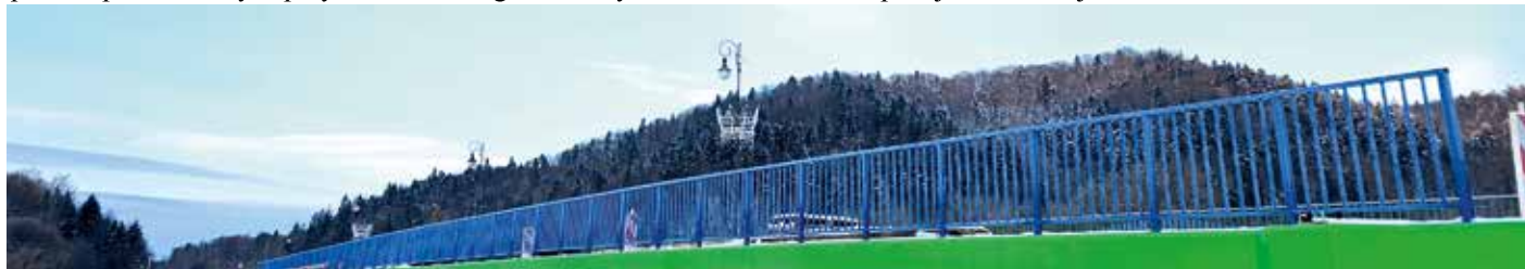
Trwające prace remontowe mostu na Popradzie - Al. Zdrojowa FOT. ARCH. UMIGU MUSZYNA
