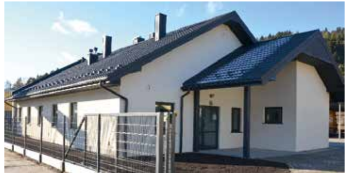
PSZOK w Powroźniku po remoncie FOT. ARCH. PGK
