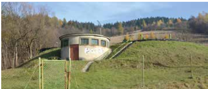
Zbiorniki wyrównawcze Malnik przed remontem FOT. ARCH. PGK
