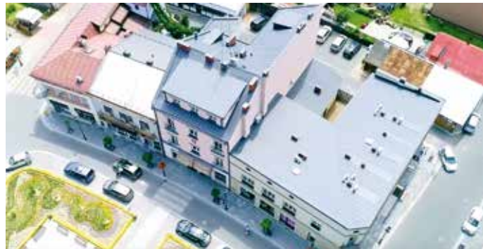
Dach po pracach remontowych FOT. M. OBIDOWSKI
