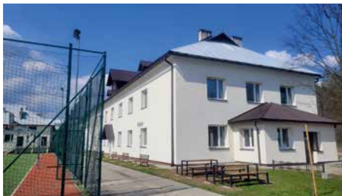
Szkoła w Powroźniku po termomodernizacji FOT. ARCH. UMIGU MUSZYNA
