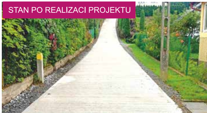
Remont drogi w Powroźniku wartość zadania: 34 tys. zł.
