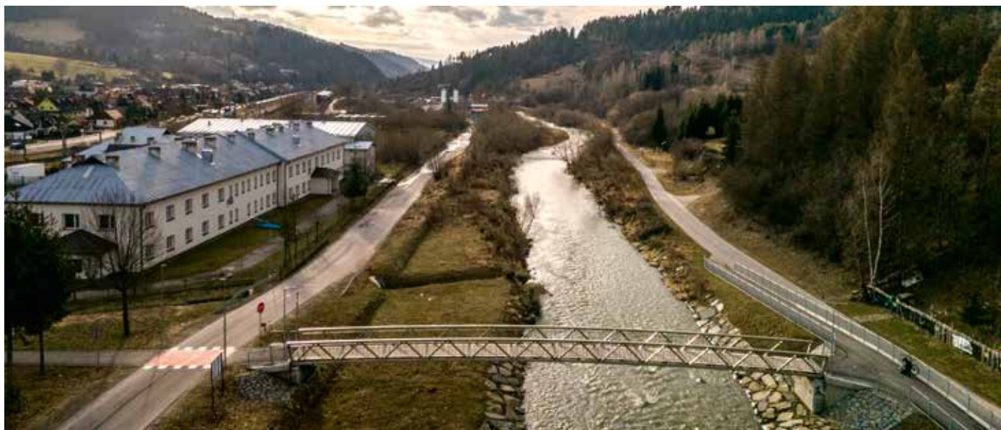
Kładka rowerowo-piesza w Powroźniku (za szkołą) FOT. K. PALUSZEK
