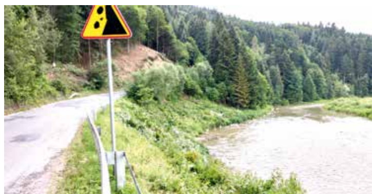
Osuwisko od strony rzeki Poprad przed zabezpieczeniem ul. Leśna FOT. ARCH. UMIGU MUSZYNA
