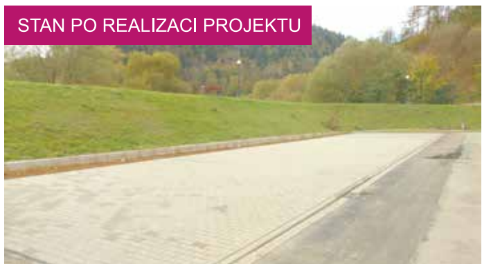
Budowa miejsc postojowych dla samochodów osobowych wartość zadania: 43 tys. zł.
