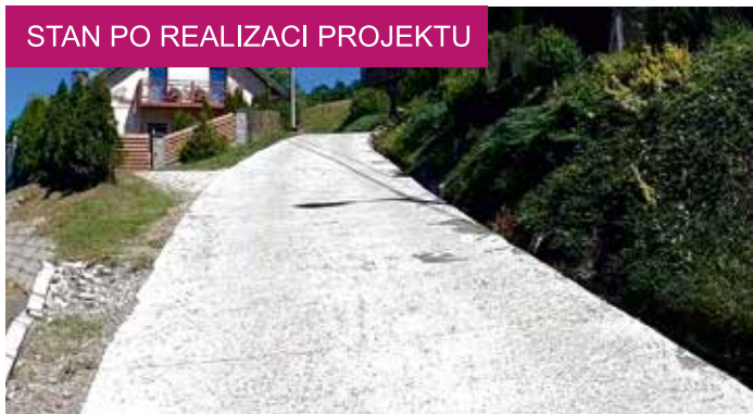
Remont drogi ul. Polna boczna wartość zadania: 86 tys. zł.
