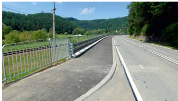
Odcinek AquaVelo - Andrzejówka po realizacji projektu FOT. ARCH. UMIGU MUSZYNA
