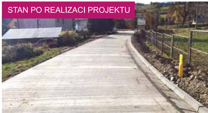
Remont drogi w Szczawniku wartość zadania: 226 tys. zł.
