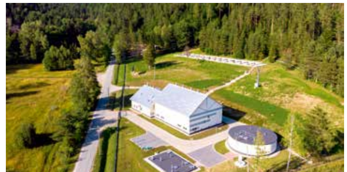
Stacja uzdatniania wody „Jasieńczyk” po modernizacji FOT. ARCH. PGK
