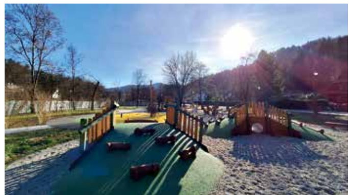
Park Rodzinny „Baszta” w trakcie robót budowlanych FOT. A. KRÓLIKOWSKI
