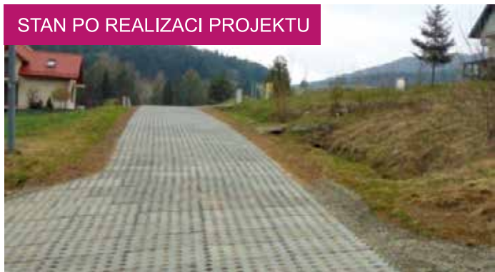
Remont drogi w Muszynie ul. Ogrodowa (boczna) wartość zadania: 13 tys. zł.
