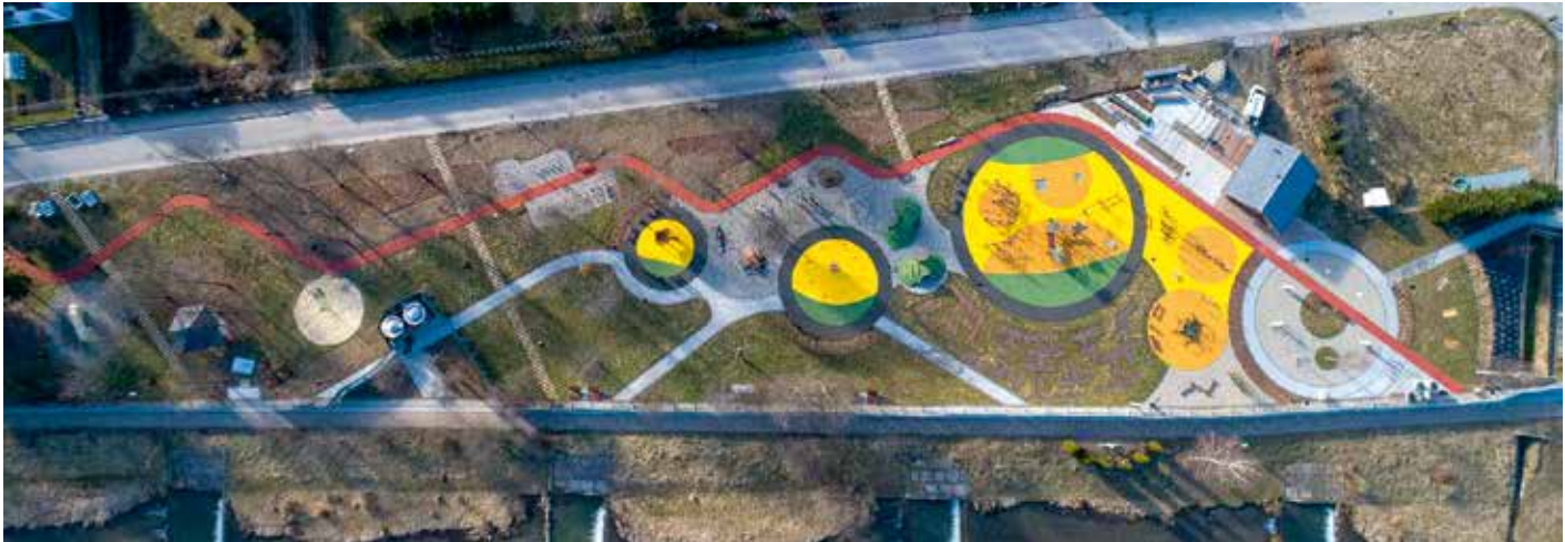
Park Rodzinny „Baszta” w trakcie robót budowlanych FOT. M. OBIDOWSKI
