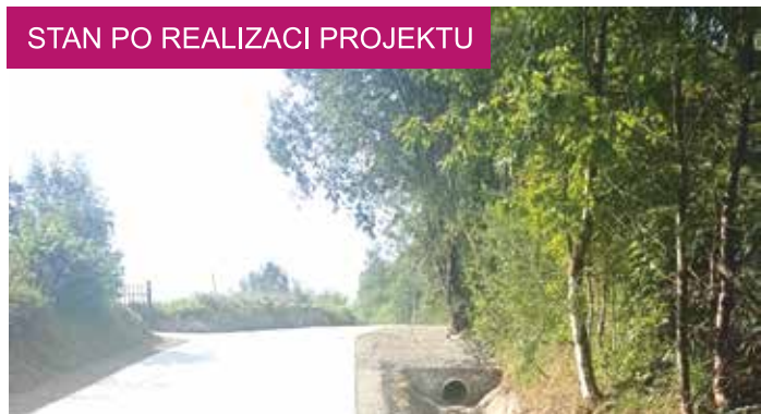
Remont drogi w Szczawniku wartość zadania: 98 tys. zł.
