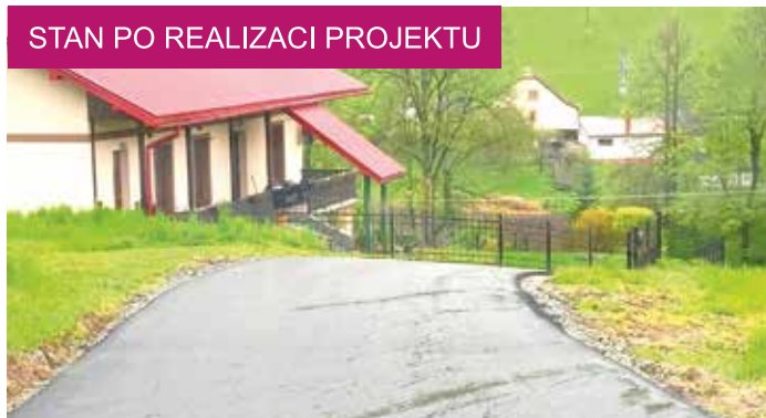
Droga do kościoła w Leluchowie po remoncie wartość zadania: 185 tys. zł.
