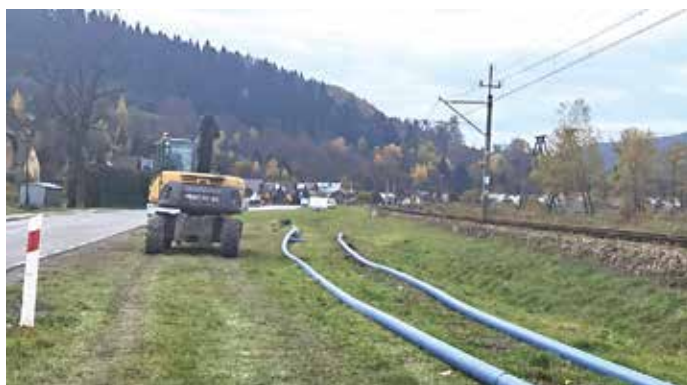
Budowa sieci wodociągowej w Powroźniku FOT. ARCH. UMIGU MUSZYŃA
