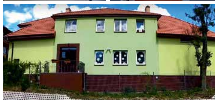
Remont w Szkole Podstawowej w Jastrzębiku
