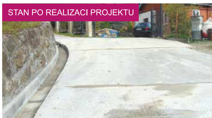
Remont drogi gminnej przy ul. Słonecznej wartość zadania: 33 tys. zł.
