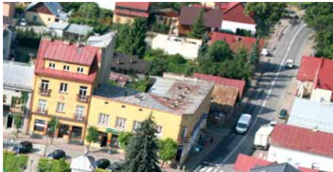
Dach przed pracami remontowymi FOT. ARCH. UMIGU MUSZYNA
