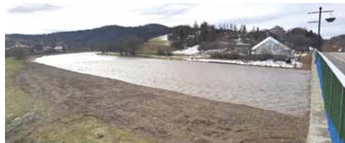
Teren po usunięciu łachy przy moście na Al. Zdrojową FOT. ARCH. UMIGU MUSZYNA
