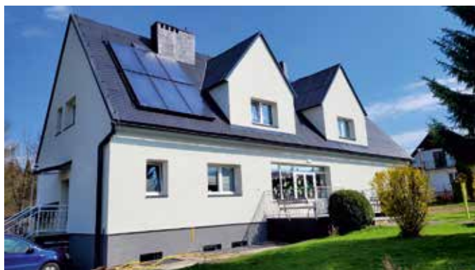
Przedszkole w Powroźniku po termomodernizacji FOT. ARCH. UMIGU MUSZYNA
