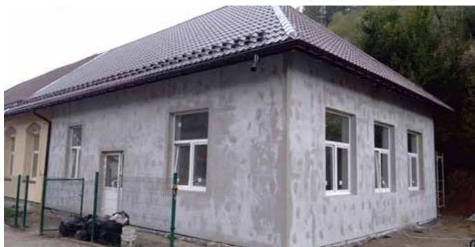
Szkoła w Miliku przed modernizacją FOT. ARCH. UMIGU MUSZYNA
