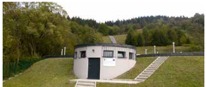
Zbiorniki wyrównawcze Malnik po remoncie FOT. ARCH. PGK
