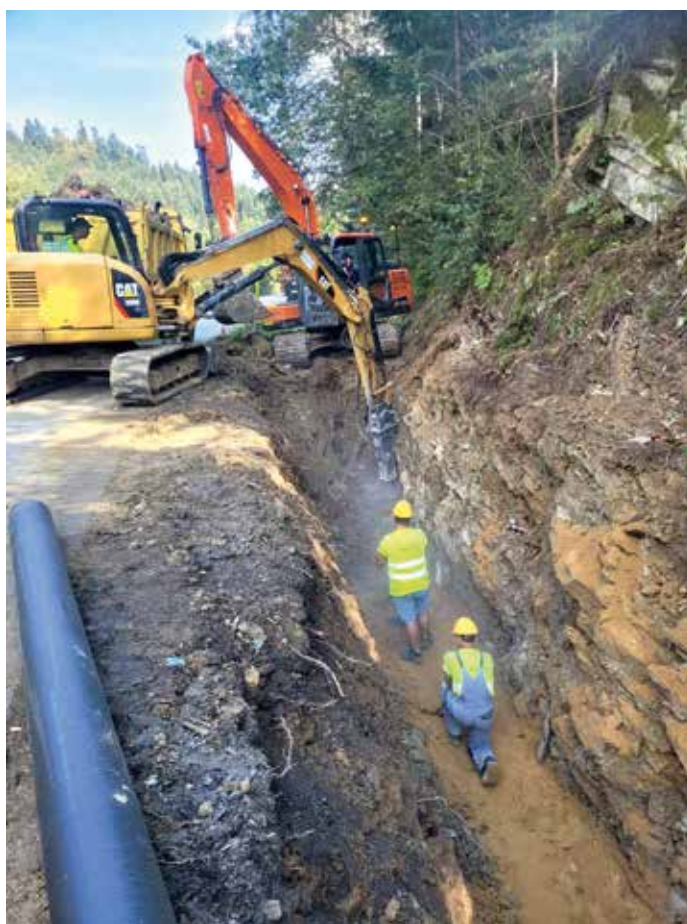
Budowa nowej sieci kanalizacji sanitarnej w Wojkowej FOT. ARCH. UMIGU MUSZYŃA
