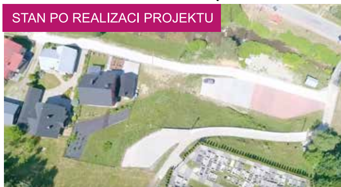
Remont drogi w Żegiestowie i nowy parking wartość zadania: 106 tys. zł.
