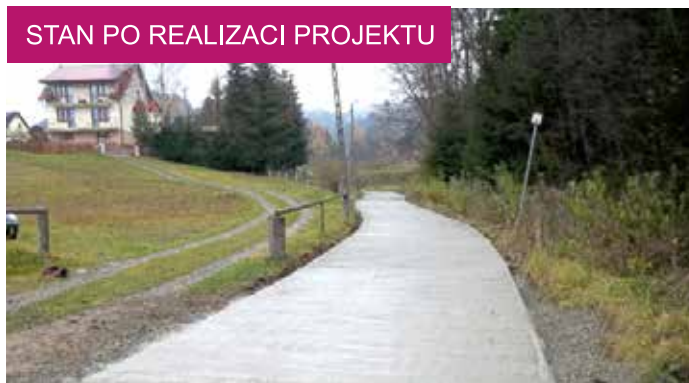
Remont drogi w Miliku wartość zadania: 130 tys. zł.
