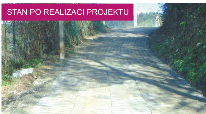
Remont drogi gminnej przy ul. Polnej wartość zadania: 27 tys. zł.
