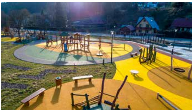
Park Rodzinny „Baszta” w trakcie robót budowlanych FOT. M. OBIDOWSKI
