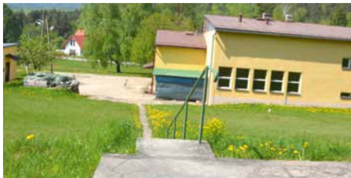
Stara stacja uzdatniania wody „Jasieńczyk” z 2018 r. FOT. ARCH. PGK
