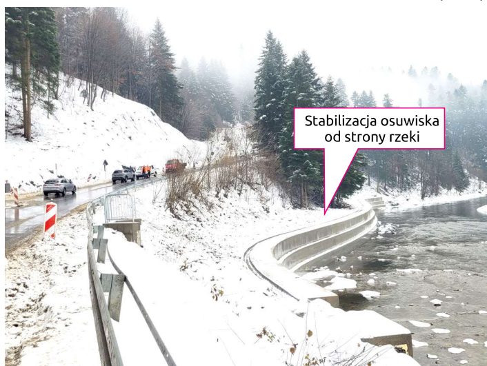
Stan po stabilizacji osuwiska ul. Leśna FOT. ARCH. UMIGU MUSZYNA
