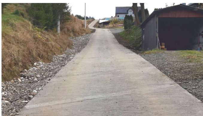
Remont drogi w Miliku Wartość projektu: 84 624 zł FOT. ARCH. UMIGU MUSZYNA
