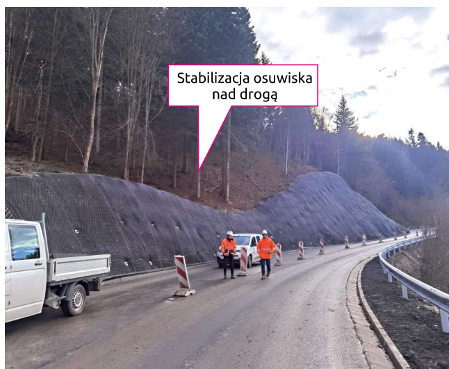
Proces stabilizacji osuwiska ul. Leśna - prace budowlane FOT. ARCH. UMIGU MUSZYNA
