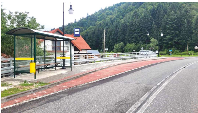
Budowa nowej zatoki autobusowej w Miliku Wartość projektu: 946 600 zł FOT. ARCH. UMIGU MUSZYNA
