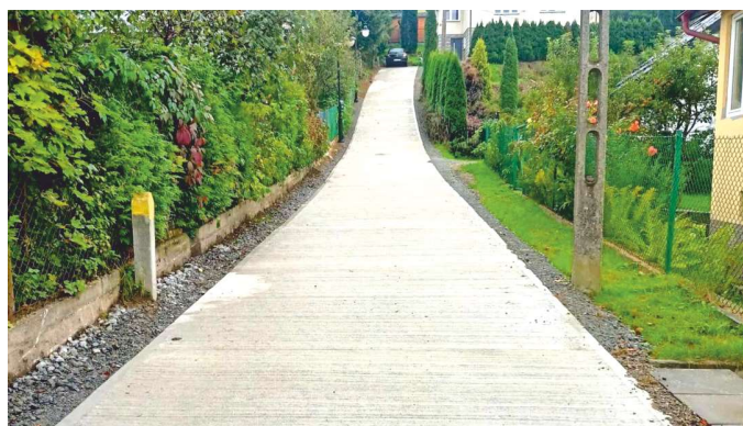
Remont drogi w Powroźniku Wartość projektu: 34 317 zł FOT. ARCH. UMIGU MUSZYNA
