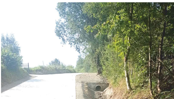
Remont drogi w Szczawniku Wartość projektu: 98 178 zł FOT. ARCH. UMIGU MUSZYNA
