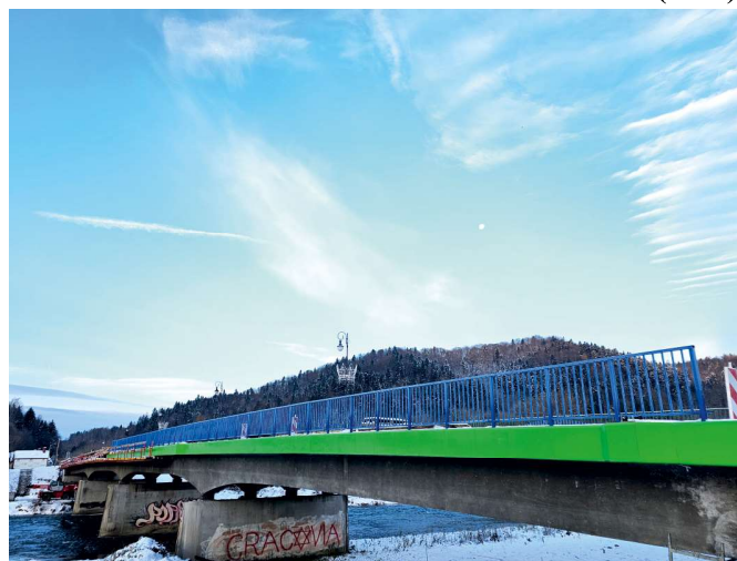
Prace remontowe mostu na rzece Poprad FOT. ARCH. UMIGU MUSZYNA
