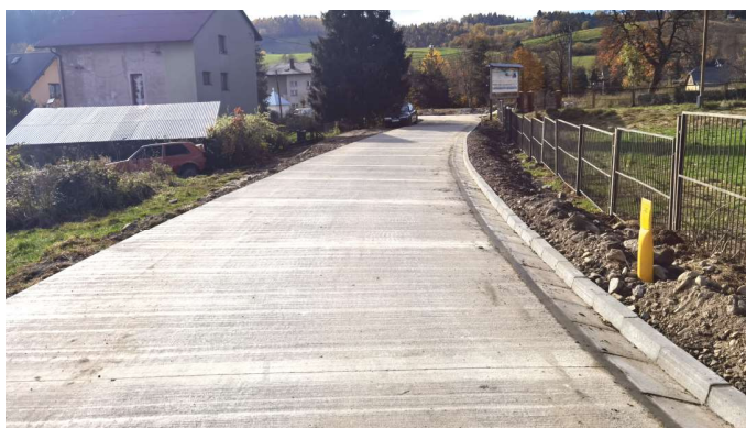
Remont drogi w Szczawniku Wartość projektu: 226 407 zł FOT. ARCH. UMIGU MUSZYNA
