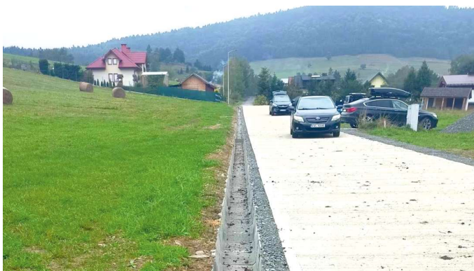
Remont drogi dojazdowej do gruntów rolnych w Jastrzębiku Wartość projektu: 120 000 zł FOT. ARCH. UMIGU MUSZYNA
