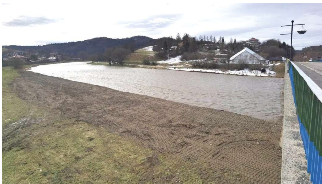
Teren po usunięciu łachy przy moście na Al. Zdrojowa FOT. ARCH. UMIGU MUSZYNA
