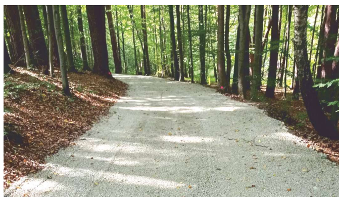
Remont drogi w Żegiestowie Wartość projektu: 84 624 zł FOT. ARCH. UMIGU MUSZYNA
