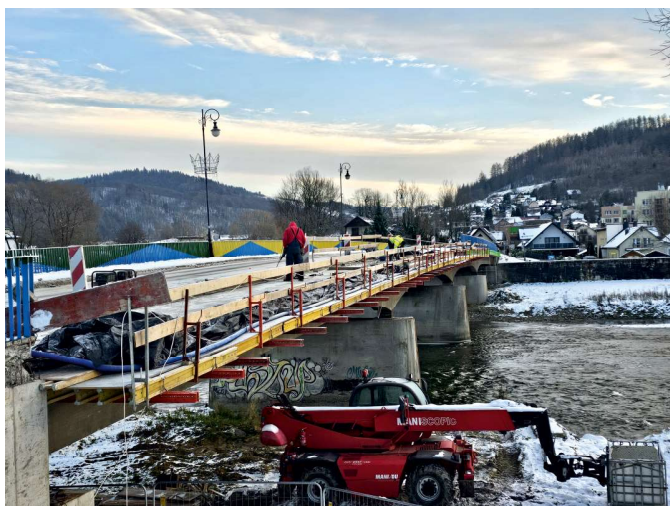
Prace remontowe mostu na rzece Poprad FOT. ARCH. UMIGU MUSZYNA
