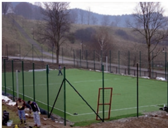
Boisko wielofunkcyjne przy szkole w Złockiem
