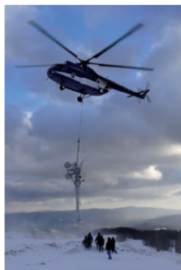
Stawianie wyciągu orczykowego w Szczawniku
