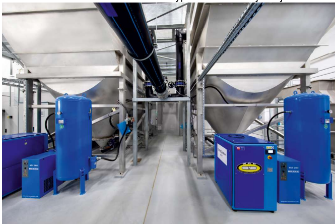
Wyposażenie nowej stacji uzdatniania wody „Jasieńczyk” FOT. ARCH. PGK
