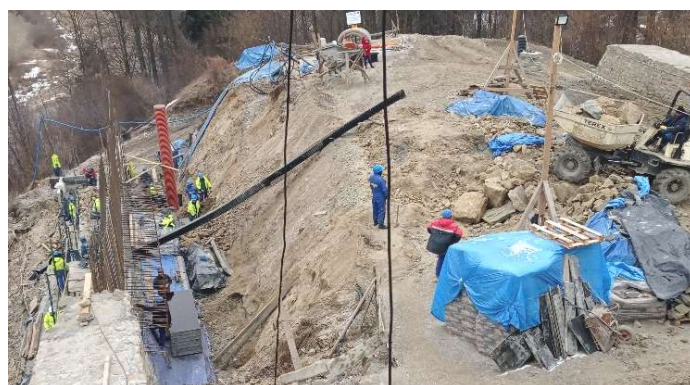
Odbudowa muru południowego FOT. ARCH. UMIGU MUSZYNA
