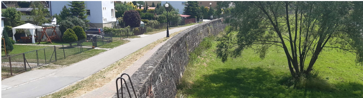
Wały przeciwpowodziowe przy ul. Piłsudskiego w Muszynie FOT. ARCH. UMIGU MUSZYNA
