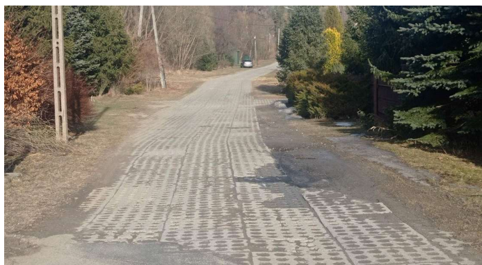
Droga na Szczawicze przed realizacją remontu FOT. ARCH. UMIGU MUSZYNA
